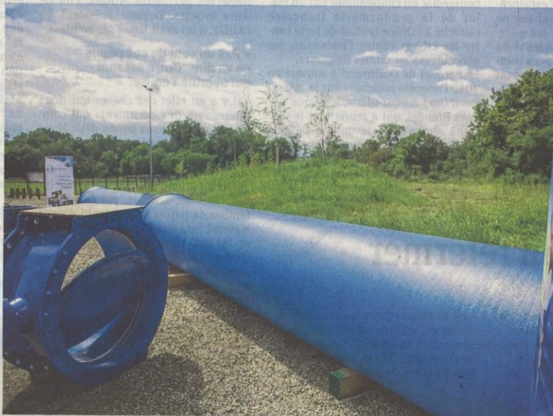
Les tuyaux font 7 m de long et entre 80 et 100 cm de diamètre. PHOTO DNA-MARC ROLLMANN
